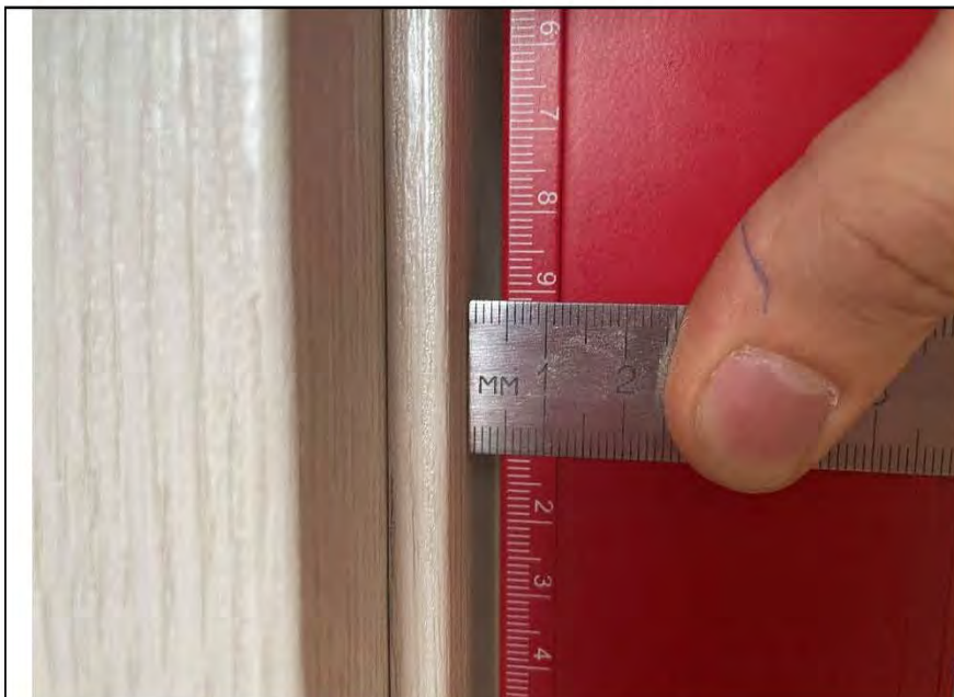
Фото №13. Измерение отклонения коробки деревянного дверного блока в спальне.
